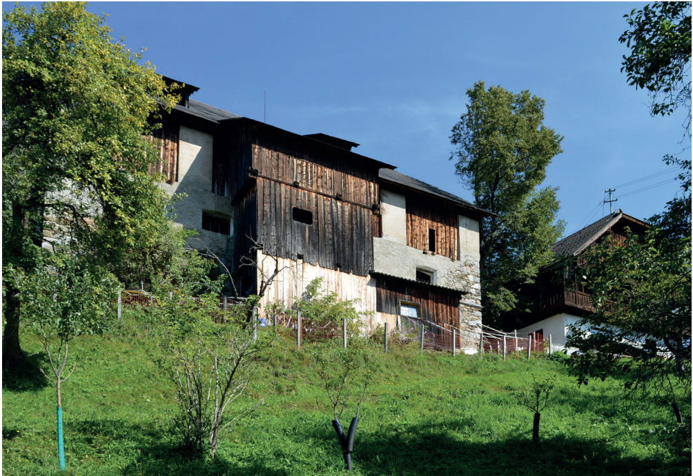
Abb 54. Wirtschaftsgebäude Ansicht vom Obstgarten und Süden
