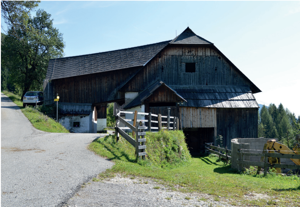
Abb 49. Ansicht auf das Wirtschaftsgebäude
