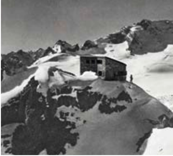
Foto: Schönweiter aus Clubhütten des S.A.C., 1931
