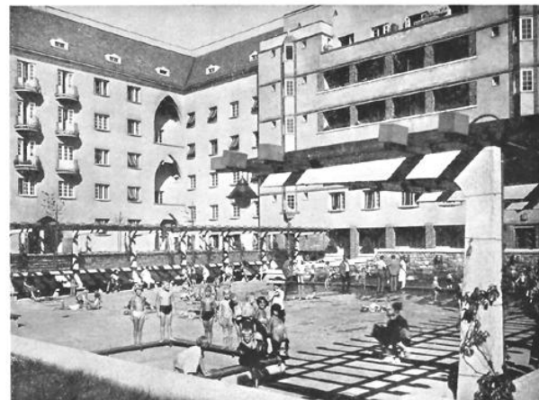
Gemeindebau Rabenhof, Wien 3, Heinrich Schmid und Hermann Aichinger, 1925 – 1928, Planschbecken im großen Hof
