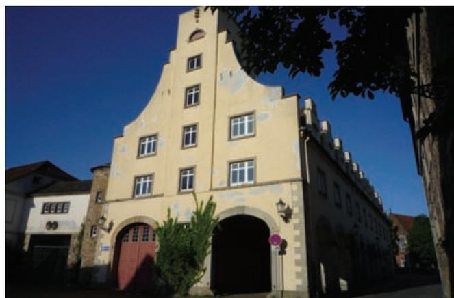
Die süd-westlich orientierte Stirnseite wird durch einen Standerker geprägt, der den dahinter liegenden 22m hohen Schlauchturm betont.
