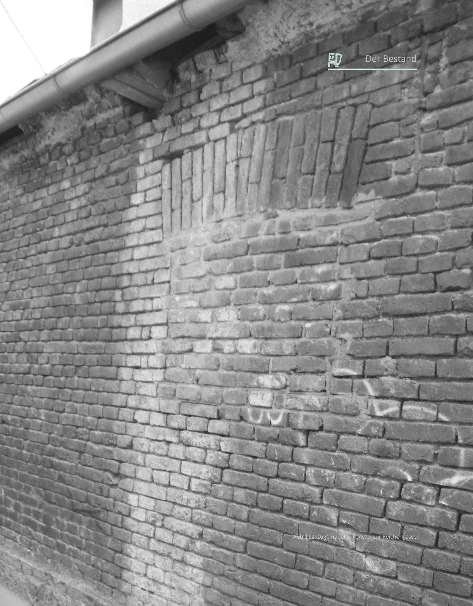
Abb. 112: zugemauerte Fenster zur Reichengasse
