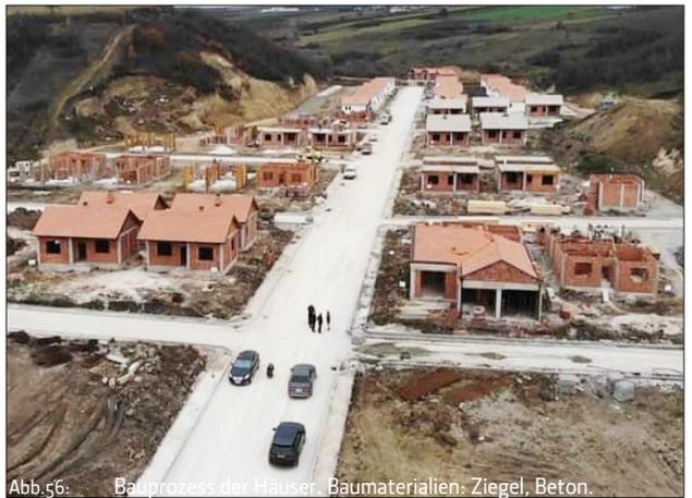
Abb.56: Bauprozess der Häuser. Baumaterialien: Ziegel, Beton.
