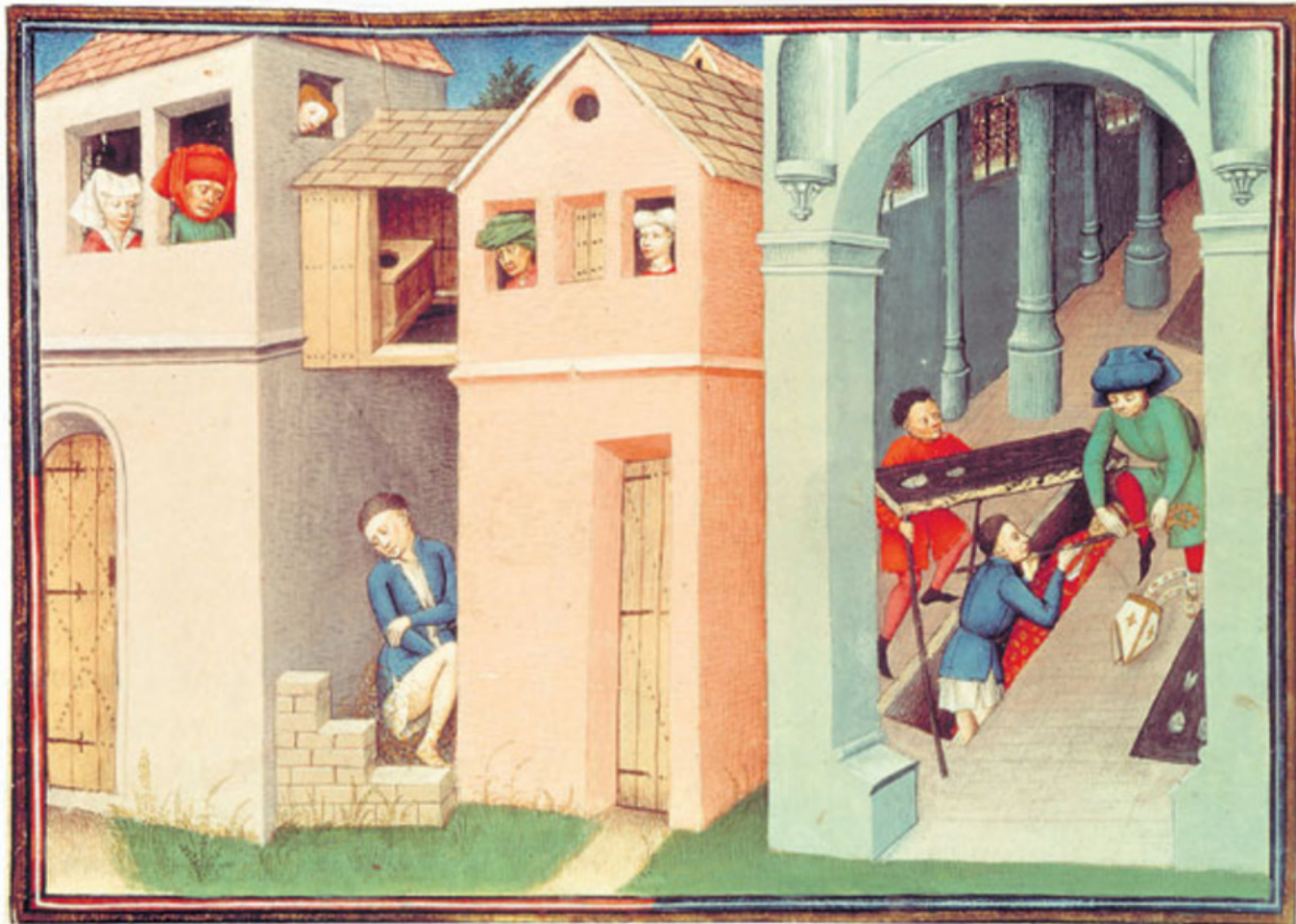
haus mit toilettenanbau im oberen stock, mittelalter
