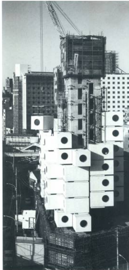
167/168 Montage des Kapselturms 169 Montageanleitung für eine Kapsel
